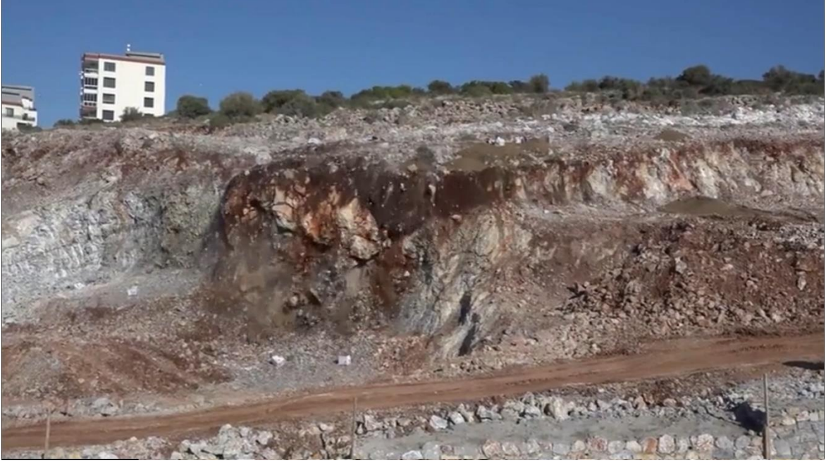
Şekil 7. Proje alanı atım esnası durum
